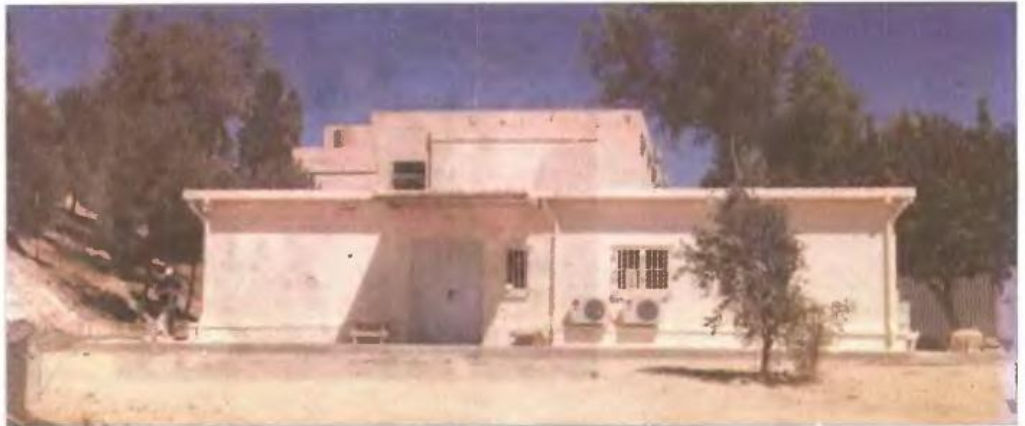
Υπεγράφη η σύμβαση για την επέκταση του κτηρίου του ΟΚΑΝΑ, που βρίσκεται κοντά στο ΠΑΓΝΗ και εξυπηρετεί όλη την ανατολική Κρήτη.
